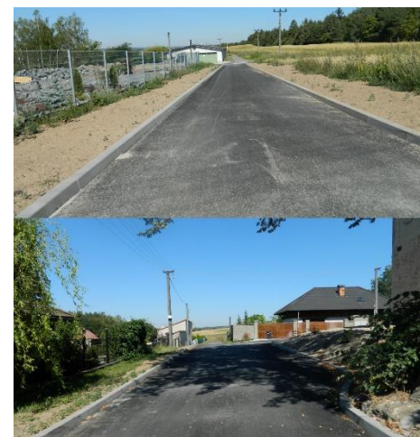
Rekonstrukce komunikací kolem staré školy vč. odvodnění v Srbech v roce 2018 – investice 3,48 mil. Kč, dotace 270 tis. Kč
